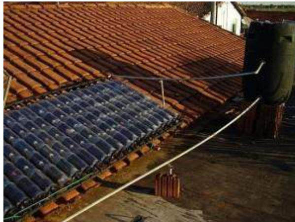
Figura 13: Sistema de aquecimento de água com garrafas pet.
