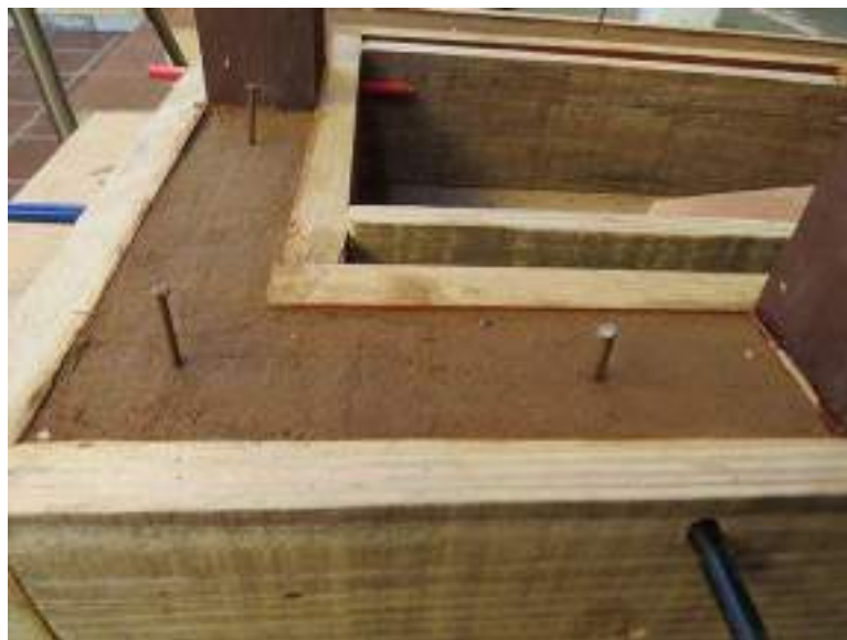
Figura 7: Parede em construção de taipa de pilão.
