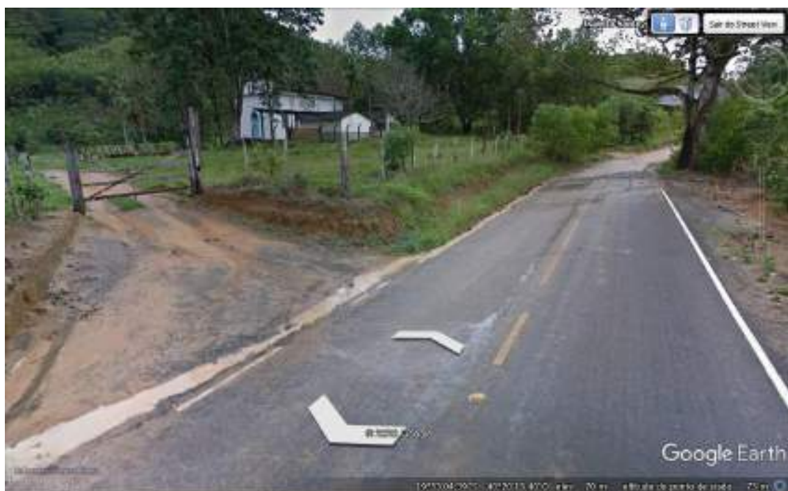
Figura 28: Estrada de acesso ao terreno, onde limita o asfalto e a estrada de chão batido
