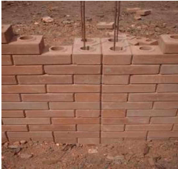
Figura 8: Tijolos de solocimento.
