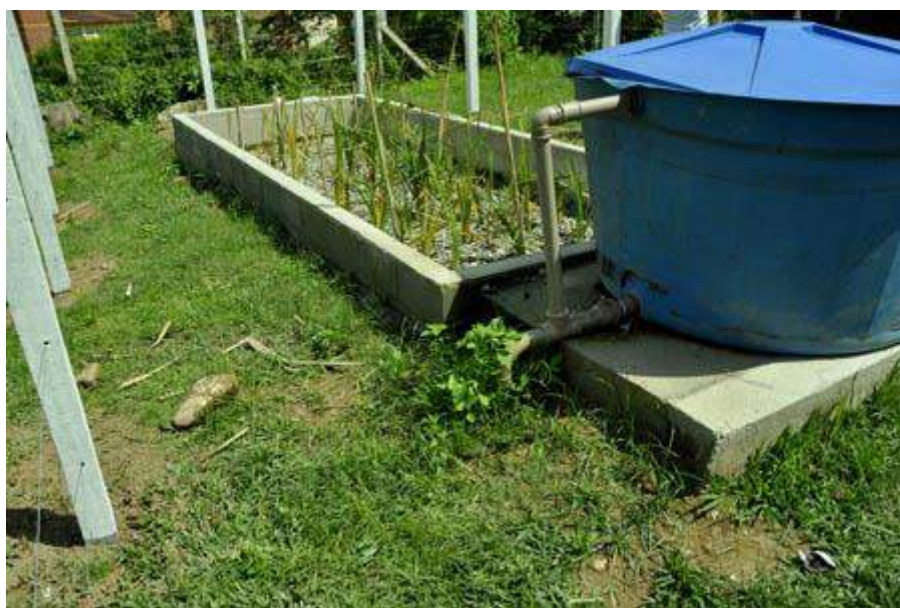
Figura 12: Tratamento zona de raízes.
