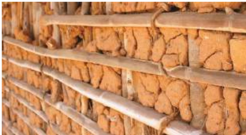
Figura 6: Parede de pau a pique.
